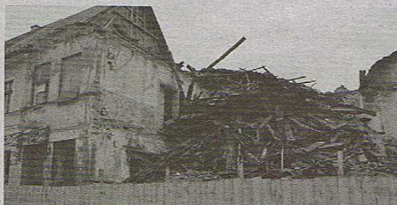
Ścianę poddasza od strony szczytu zabezpieczyli folią strącający.
